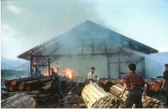
Bild 11: Der Totalschaden konnte nicht mehr abgewendet werden.
