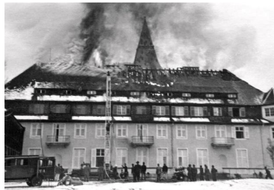
Bild 7: Ein Großbrand im Schloss Elmau am 3.12.1957 richtete erheblichen Schaden am Dachstuhl an. Er wurde mit den umliegenden Nachbarwehren aus Wallgau, Mittenwald, Partenkirchen, Garmisch und Oberammergau gelöscht.
