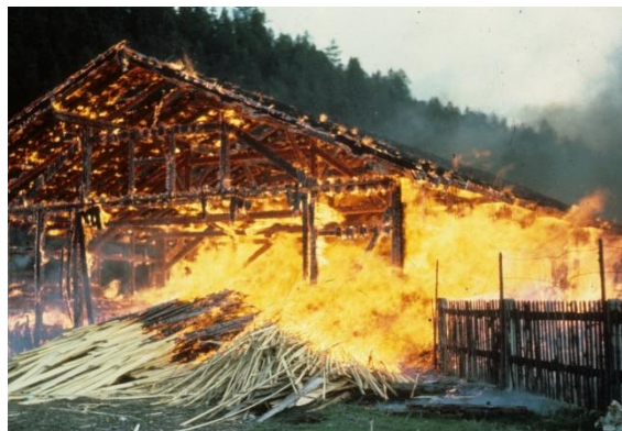
Bild 10: Großbrand am 2. Mai 1966 im Sägewerk in Krün
